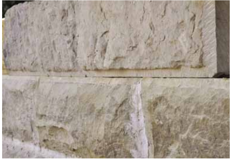
FIG. 21. Le joint horizontal avant l'ajustement par sciage.
