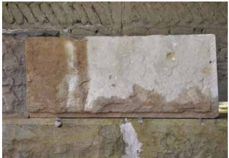
FIG. 22. Sciage horizontal en cours. Deux coins bloqués dans le trait de scie maintiennent le bloc dans sa position d'origine; un troisième va être inséré juste en arrière de la position actuelle de la scie (à gauche) avant qu'elle n'atteigne la fin du joint.
