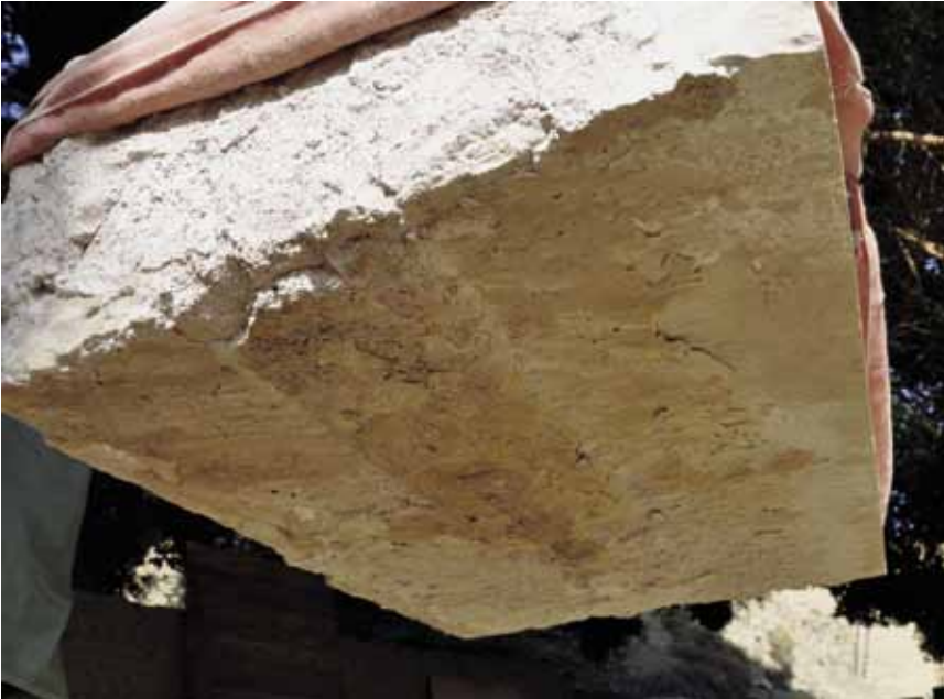
FIG. 30. Le lit de pose après levage du bloc. L'utilisation d'un coulis se reconnaît par l'irrégularité de sa propagation sur sa face de joint. Cet aspect du coulis peut parfois être observé sur des blocs déchaussés de monuments antiques.
